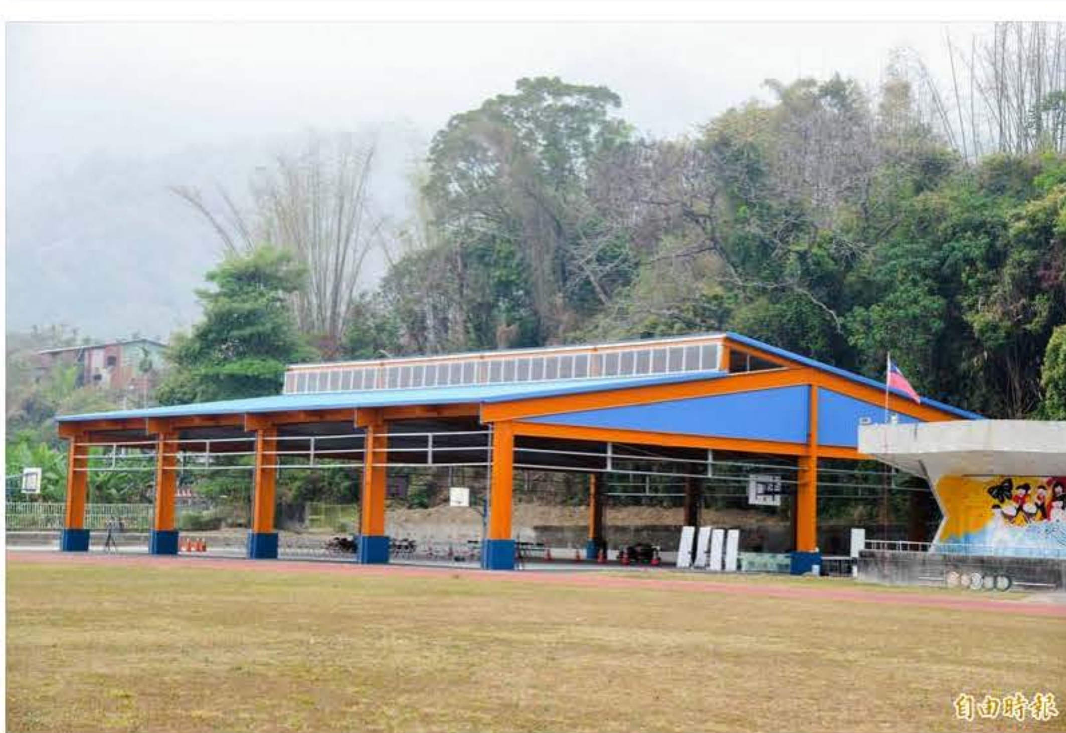
六龜高中風雨球場約1個籃球場大，特別壓低屋頂高度，減少大雨時雨水滲入，屋頂上也有透光板設計。（記者許麗娟攝）
